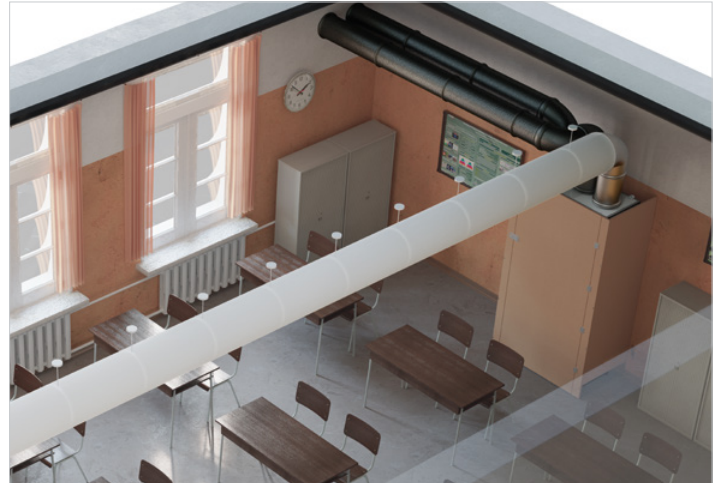
Aufstellung im Raum mit Trockenbau und Textilschlauch
