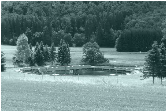
Ansteuerung von Pumpen, Bojen, ...
